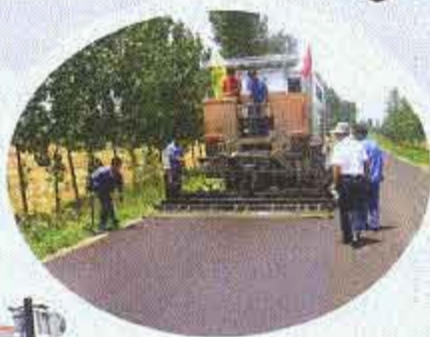
微表封层 施工现场
