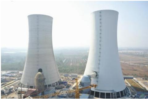
平山电厂安装的自然通风冷却塔
