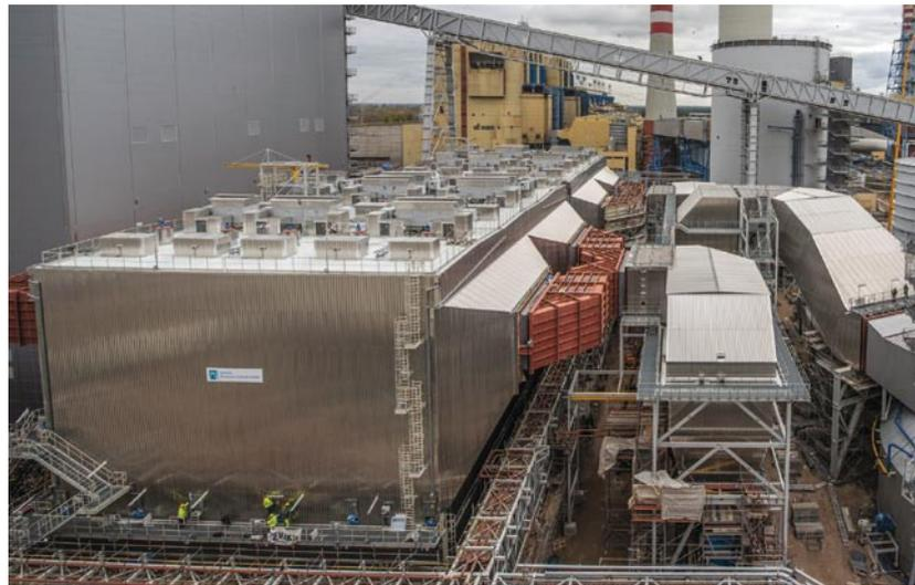
应用在火电厂的静电除尘器
