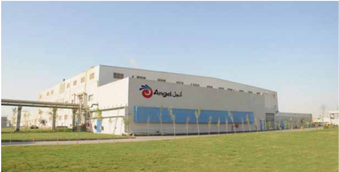
图 3-8 安琪埃及公司厂房外貌 ①
